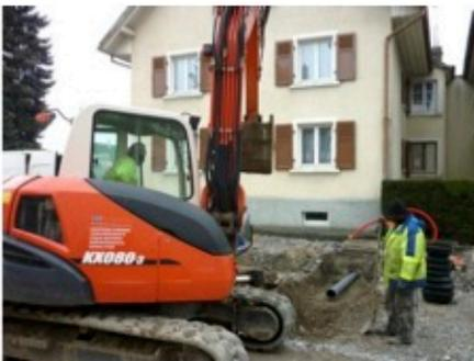
Pose des siphons d'évacuation d'eau pluviale. C'est bien de voir grâce à René ce qui est caché d'habitude. "Un point positif ! On est rassuré que les eaux pluviales descendent la Vallée de l'Ill !"
